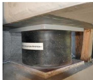
diseño de cualquier tipo de estructura en la cual se busca aumentar el grado de confiabilidad del diseño. El 100% de los aisladores sísmicos utilizados en el proyecto fue sometido a ensayos en los laboratorios del fabricante en Estados Unidos, laboratorio que contaba con todas las certificaciones de calibración de equipos requeridas por la normativa chilena y norteamericana.
