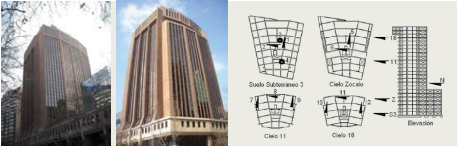
FIGURA 3. EDIFICIO CÁMARA CHILENA DE LA CONSTRUCCIÓN. VISTAS Y DISPOSICIÓN DE ACELERÓMETROS
